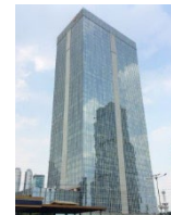
インドネシアテクニカルセンター
