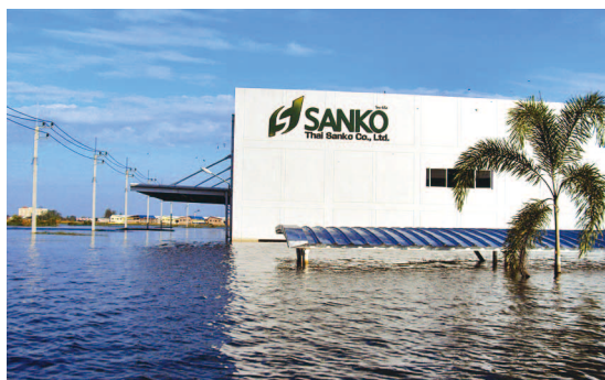
2011年9月に発生した洪水ではロジャナ工業団地一帯も浸水
